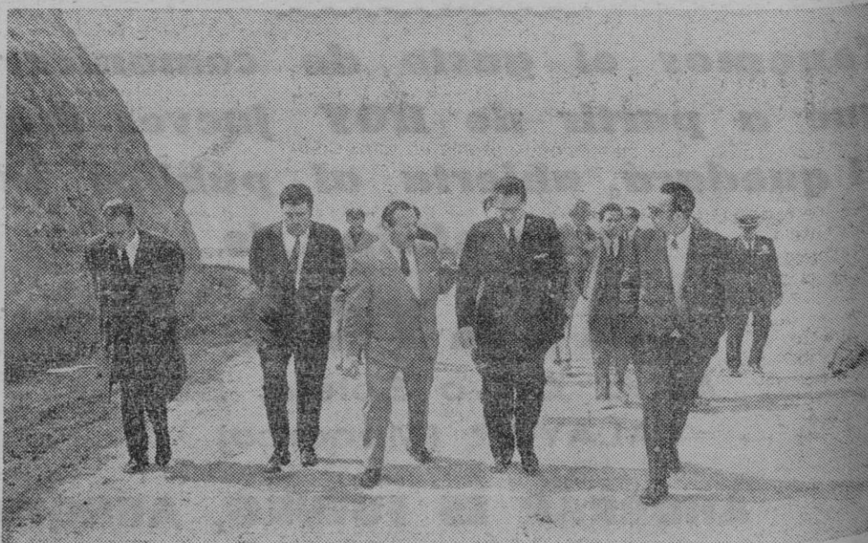
Durante su recorrido de ayer, el Gobernador se detuvo en la Urbanización «El Toro», mostrándose muy interesado por las obras de acondicionamiento de la playa ubicada allí. En la fotografía, nuestra primera autoridad civil y acompañantes, con don Pedro Nadal Salas.
