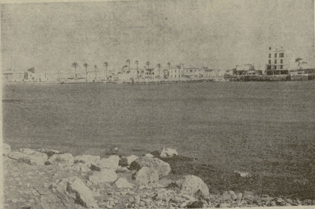
DESDE ESTE PUNTO, LA ENTRADA AL CLUB NAUTICO DEL PORTITXOL, ES NECESARIO COMENZAR LAS OPERACIONES DE DRAGADO.
