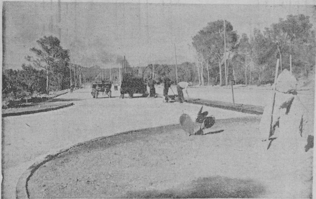
La «Operación asfaltado» en la Urbanización «EL TORO», está prácticamente terminada, como habíamos anunciado. Hoy, a muchos meses vista de la temporada estival, está la Urbanización prácticamente a punto. Lo más indispensable, agua, alcantarillado, asfalto, luz, etc., son obras culminadas o están muy próximas a verse coronadas por el éxito. Y en este maravilloso marco de «EL TORO», está ubicado el Primer Premio de nuestra «Cesta»: el Apartamento de Lujo, obsequio de don Pedro Nadal Salas, Director - Propietario de Construcciones NASA.
