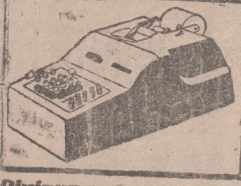
Calculadora impresora eléctrica que efectúa las cuatro operaciones, da los soldos negativos e imprime factores y resultados.
