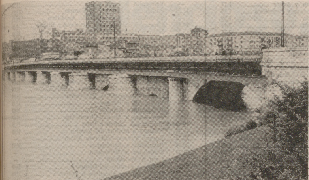
Las aguas del Pisuerga tapan casi los ojos del Puente Mayor.
