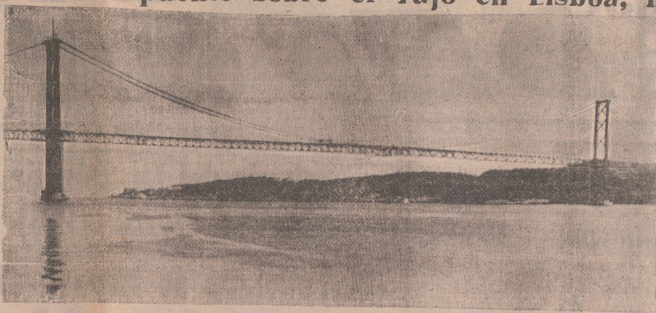
Tras la colocación de la última "pieza" en la estructura metálica del enorme puente sobre el río Tajo que se está construyendo en Lisboa, éste es el aspecto panorámico que ofrece. Se trata de uno de los puentes más largos del mundo. — (Foto "Fiel").
