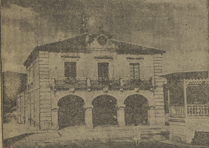
Sobriedad y elegancia se compaginan armoniosamente en la fachada de la Casa Consistorial, de estilo castellano, en el que la piedra se funde en los arcos, alisos y en los soportales
