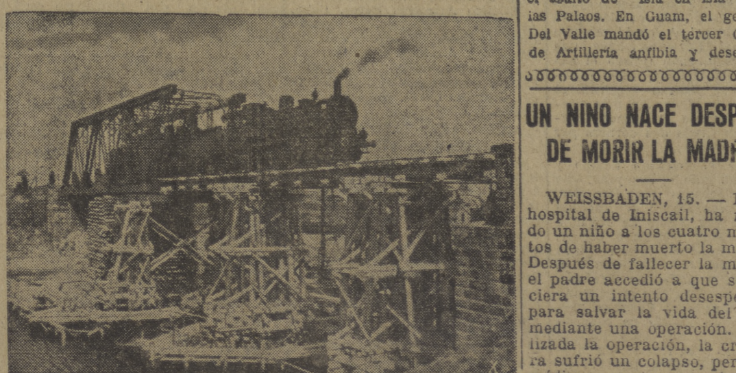
Puede del ferrocarril, en la región de Anguiera, que fue roto por unos sabotadores y que acaba de ser reparado para poder transportar el vicio a la capital.
