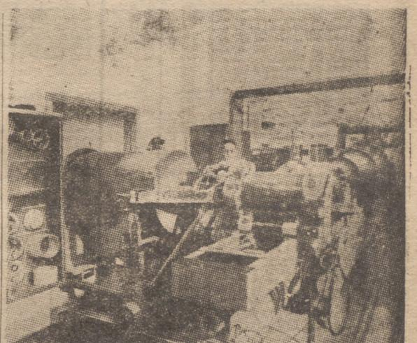
Cabeza del túnel, donde está situada la cámara de arco, que recibe una energía eléctrica de siete millones de vatios-segundo, procedente de la sala de condensadores, situada a la izquierda. La energía descargada en la cámara de arco es la que eleva la temperatura del aire a 14.000 grados Fahrenheit, y su presión, a 3.000 libras por pulgada cuadrada. (Foto As Press.)
