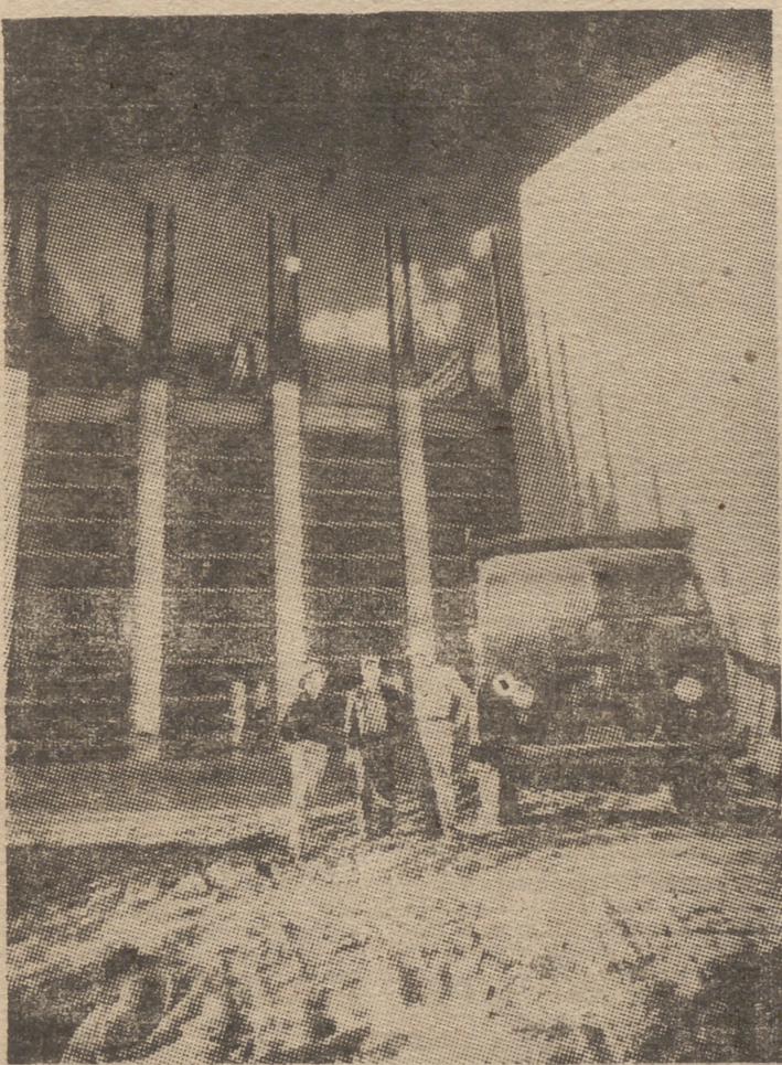
Un aspecto de la construcción de la nueva capital del Brasil.
