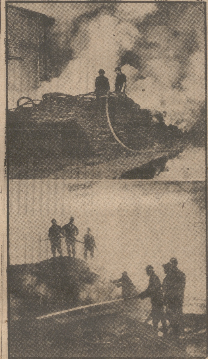
Gracias a los denodados esfuerzos de los bomberos de Bilbao, el voraz incendio registrado hace tres días en el puerto franco de Santurce no tuvo las gravísimas consecuencias que se temieron en un principio. Iniciado el siniestro en una gabarra que portaba sacos de nitrato de Chile, las llamas consumieron el cargamento, pero logró evitarse su propagación a otras embarcaciones. Las presentes fotografías recogen dos aspectos de los arduos trabajos que se realizaron para extinguir el fuego.
