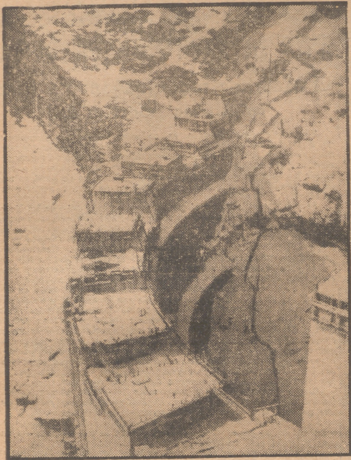
La enorme presa, ya prácticamente terminada, en los Alpes de la Saboya, cerca de la frontera italiana, y que habrá de reportar a Francia 800 millones de kilovatios-hora. Los habitantes de Tignes, pueblo que ha desaparecido como consecuencia de la construcción, han sido trasladados a otra localidad recientemente edificada. Sin embargo, sesenta de los vecinos amenazan con dejarse morir en sus hogares como protesta contra la destrucción del pueblo. (Foto A. P.)
