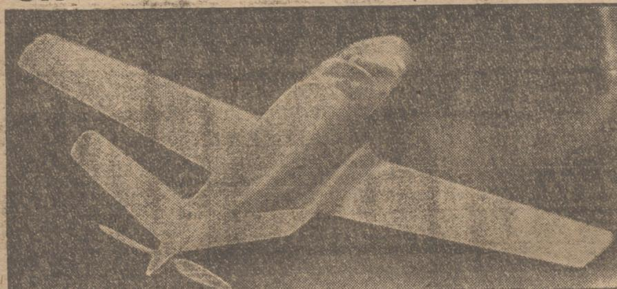
En Croydon se está construyendo este avión, que estará en disposición de vuelo a fin de año. Será el primer modelo con el motor en cola. Tendrá cinco asientos, una velocidad de 180 millas por hora y su precio será de 3.000 libras. (Foto A. P.)
