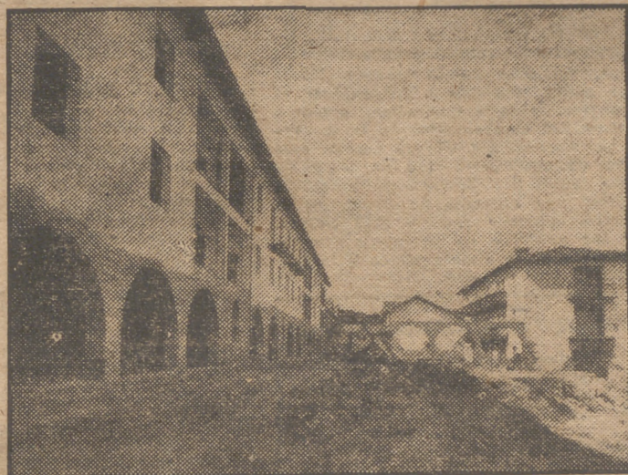
Viviendas protegidas que se construyen actualmente en Fuenterrabía, cuyos trabajos corren a cargo de la importante firma constructora Echebarría y Cia., S. L., de Irún.
