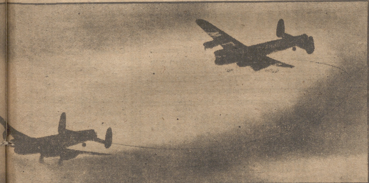
gasolina y aceite en vuelo, que hace unos años constituyó un ensayo audaz, hoy es medio corriente empleado en las líneas aéreas. He aquí el momento de enlazar un avión de la British Sout American con su "nodriza" en pleno vuelo. Es lanzada por un arpón y recogida en el avión de pasajeros. A 12.000 pies de altura, en 23 minutos los Lancaster recibieron mil galones de gasolina. (Foto Planel.)
