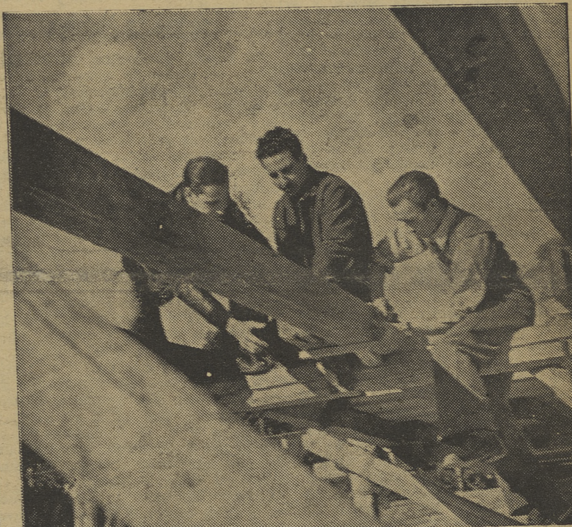
Alumnos de la Sección de Ingenieros, construyendo un puente
