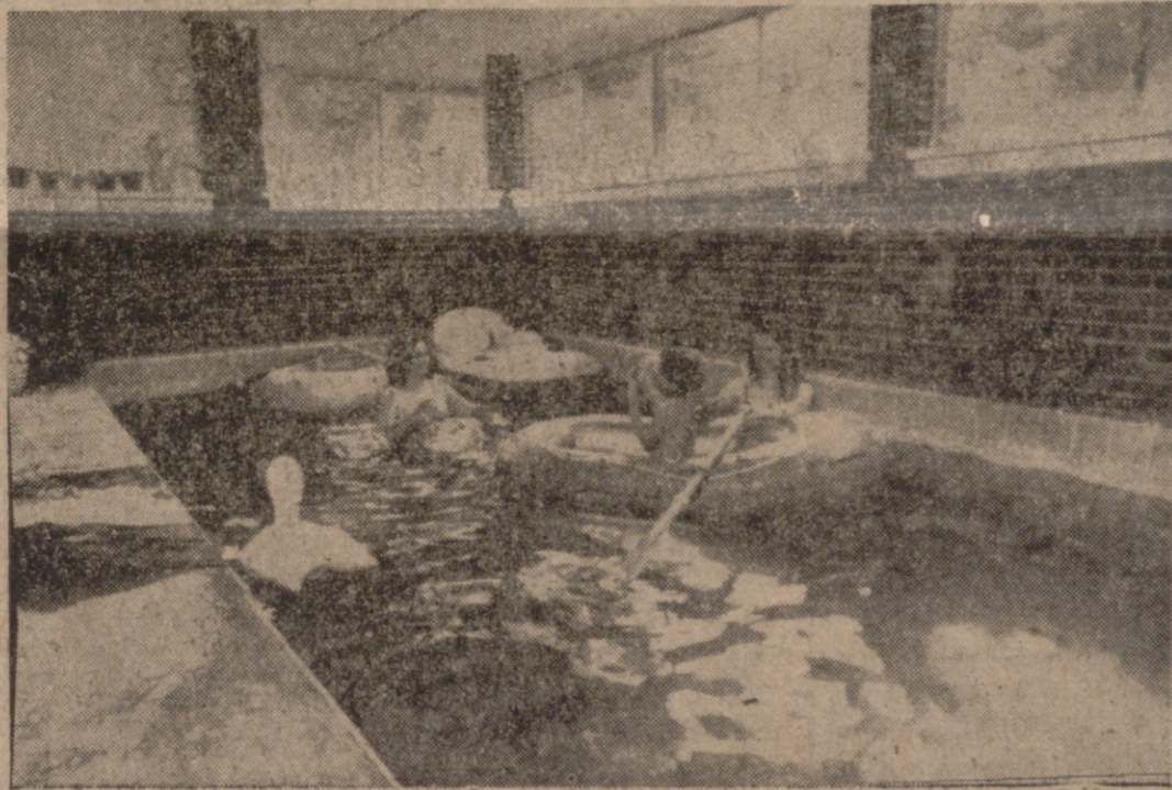
DISTRITO ALTO (Maryland, Estados Unidos).—En la casa del abogado e inventor Harry Thomson, el noventa por ciento de la calefacción se obtiene mediante el calor solar. La familia puede utilizar la piscina durante nueve meses, porque el agua está caliente por las placas solares situadas en el tejado.—(Foto Cifra Gráfica.)
