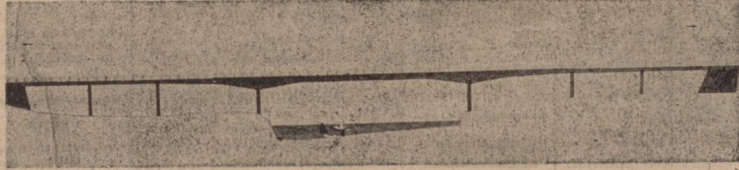
PERFIL LONGITUDINAL DEL VIADUCTO SOBRE EL DUERO, DE CERCA DE 150 METROS, CON EL RIO ENCAJONADO.
