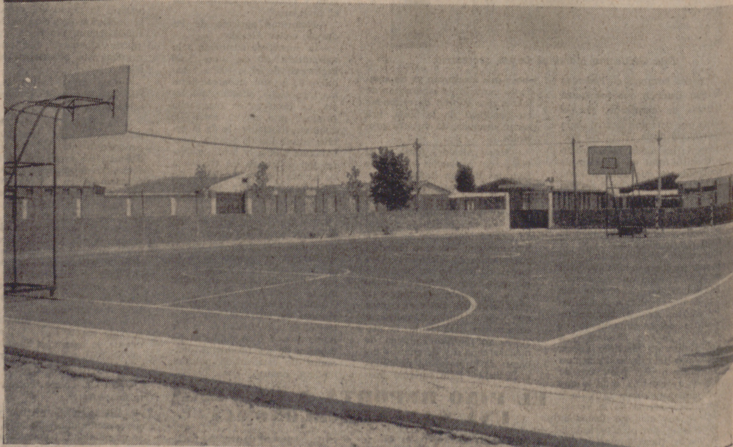
LA NUEVA PISTA POLIDEPORTIVA EN EL COMPLEJO DEPORTIVO «SAN JUAN»
