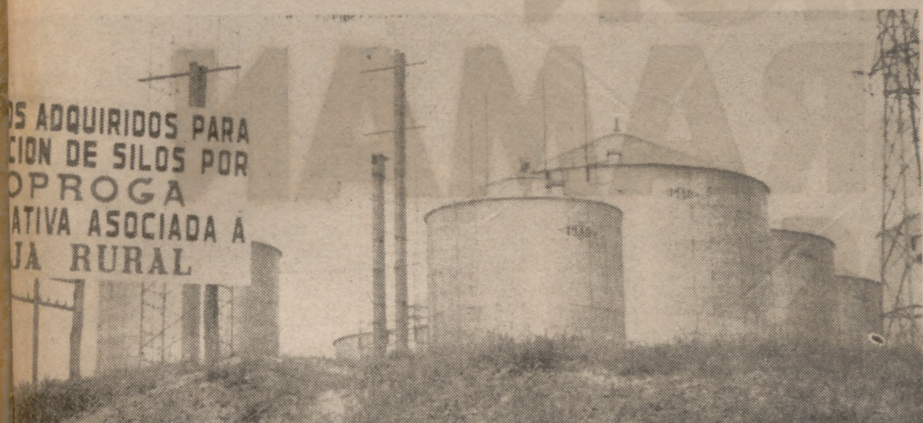
Seis de los siete silos recientemente montados por la Cooperativa Comarcal Ganadera de Tierra de Campos, con una capacidad para cien mil vagones, equivalentes a la producción de un futuro inmediato con nuevos silos con capacidad para ciento ochenta vagones más.
