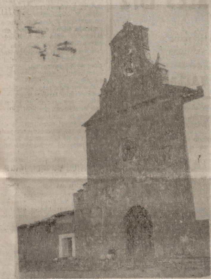
Fachada con entrada, y en lo alto la espadaña conventual de los RR. PP. Franciscanos. Este templo, abandonado por los Franciscanos a raíz de la "desamortización" de Mendizábal, lo tomó a su cargo la tordesillana Orden Tercera. Recientemente, este templo ha sido despojado de sus objetos de valor. Desaparecido el culto, es otra presunta y lamentable ruina. ¿Por qué no se ofrece a alguna institución cultural con la obligación de sólo mantenerlo en pie? El Teleclub carece de sede.
