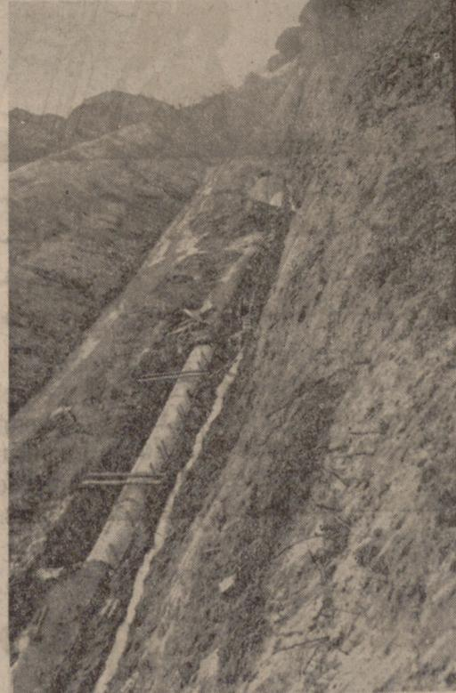
Al fondo de la zanja se ve perfectamente el encañado del tubo que ha de conducir las aguas de la laguna. Arriba y abajo van depositando hormigón, rico en cemento.—(Foto Carvajal.)
