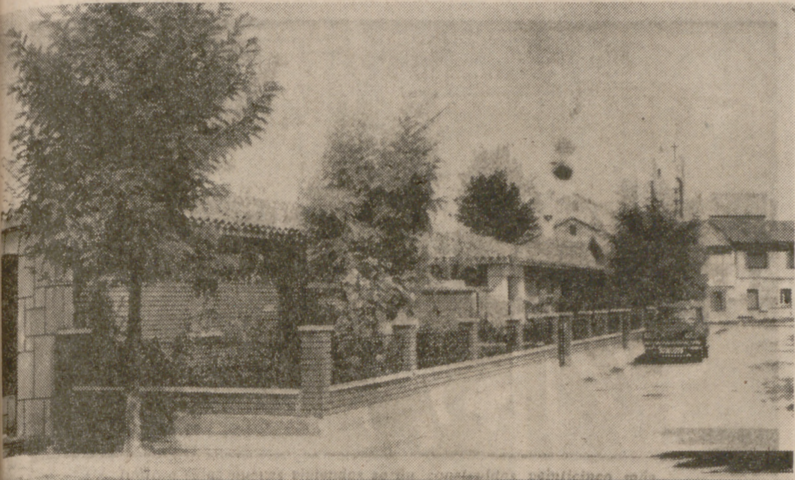
Junto a estas nuevas viviendas serán construidas veinticinco más.
