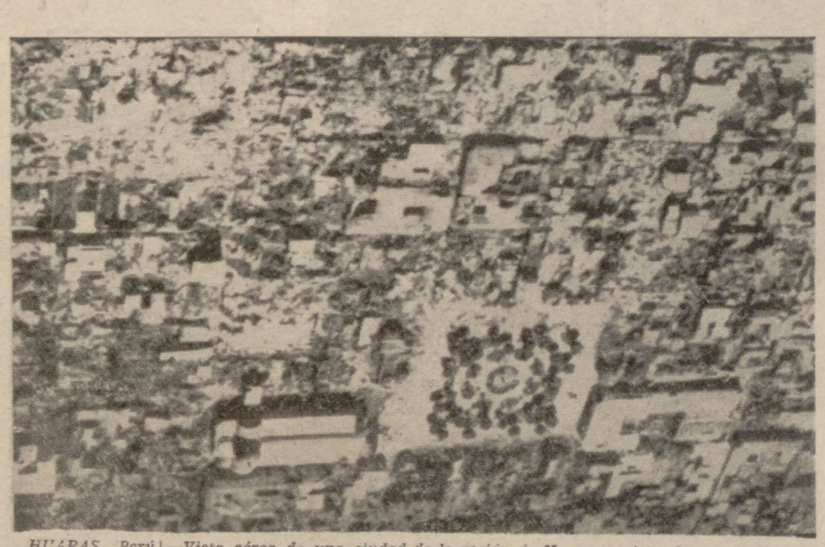
HUARAS (Perú).—Vista aérea de una ciudad de la región de Huaras casi totalmente destruida por el terremoto que conmovió al país recientemente.—(Telefoto Upi-Cifra.)
