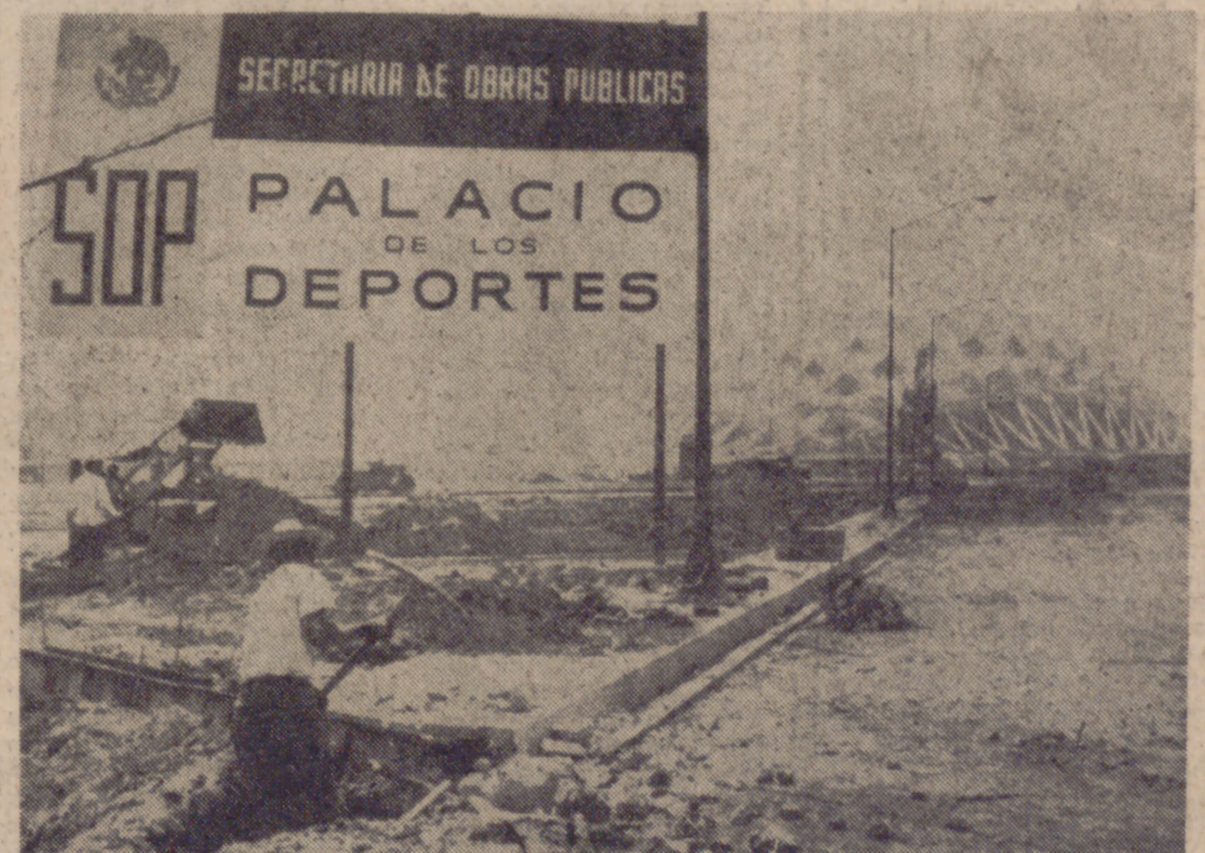
MEXICO.—Los trabajadores laboran en los alrededores de la cúpula geodésica del Palacio de Deportes, donde tendrá cabida buen número de deportes de la Olimpiada. (Telefoto Upi-Cifra)
