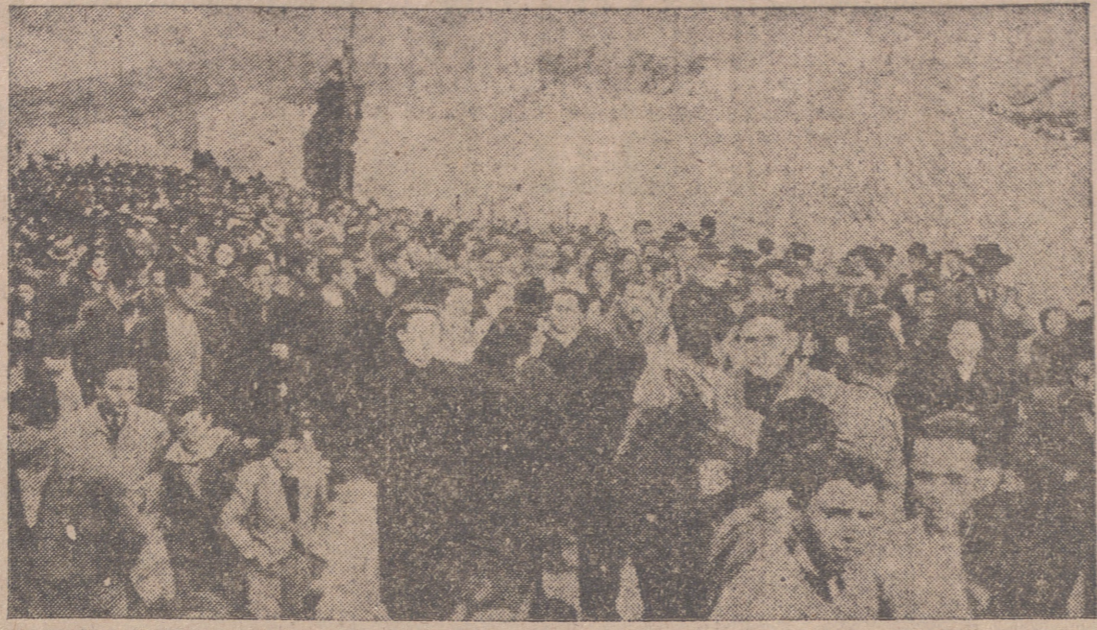
Granada.—El gobernador civil de la provincia, acompañado del alcalde y otras autoridades locales, y seguido por los habitantes de este pueblo, durante la visita a las diversas barriadas de casas del Patronato de Santa Adela con destino a dichos trabajadores. También se inauguraron importantísimas reformas urbanas que embellecen esta localidad de origen árabe. (Foto Cifra Gráfica.)
