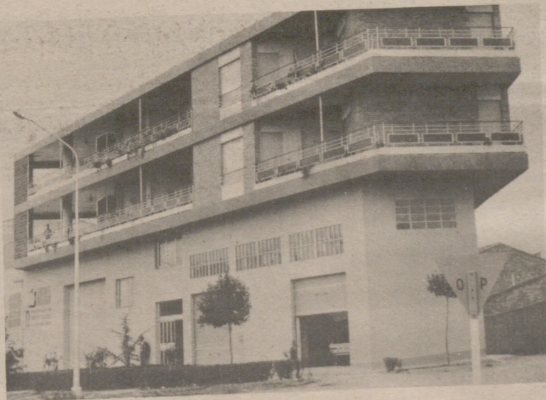
Grupo de viviendas con instalación de propano
