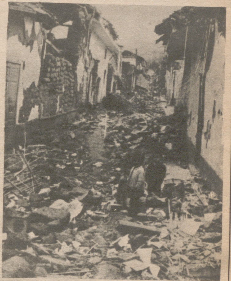
PERU.— Tres pequeños, supervivientes de los terremotos que han asolado la zona norte y centro de Perú, aparecen entre los escombros de una calle de la ciudad de Huaraz. La población ofrece un aspecto de increíble devastación. El temblor dejó su más expresiva marca en Huaraz, debido a lo compacto de sus casas y la estrechez de sus calles.
