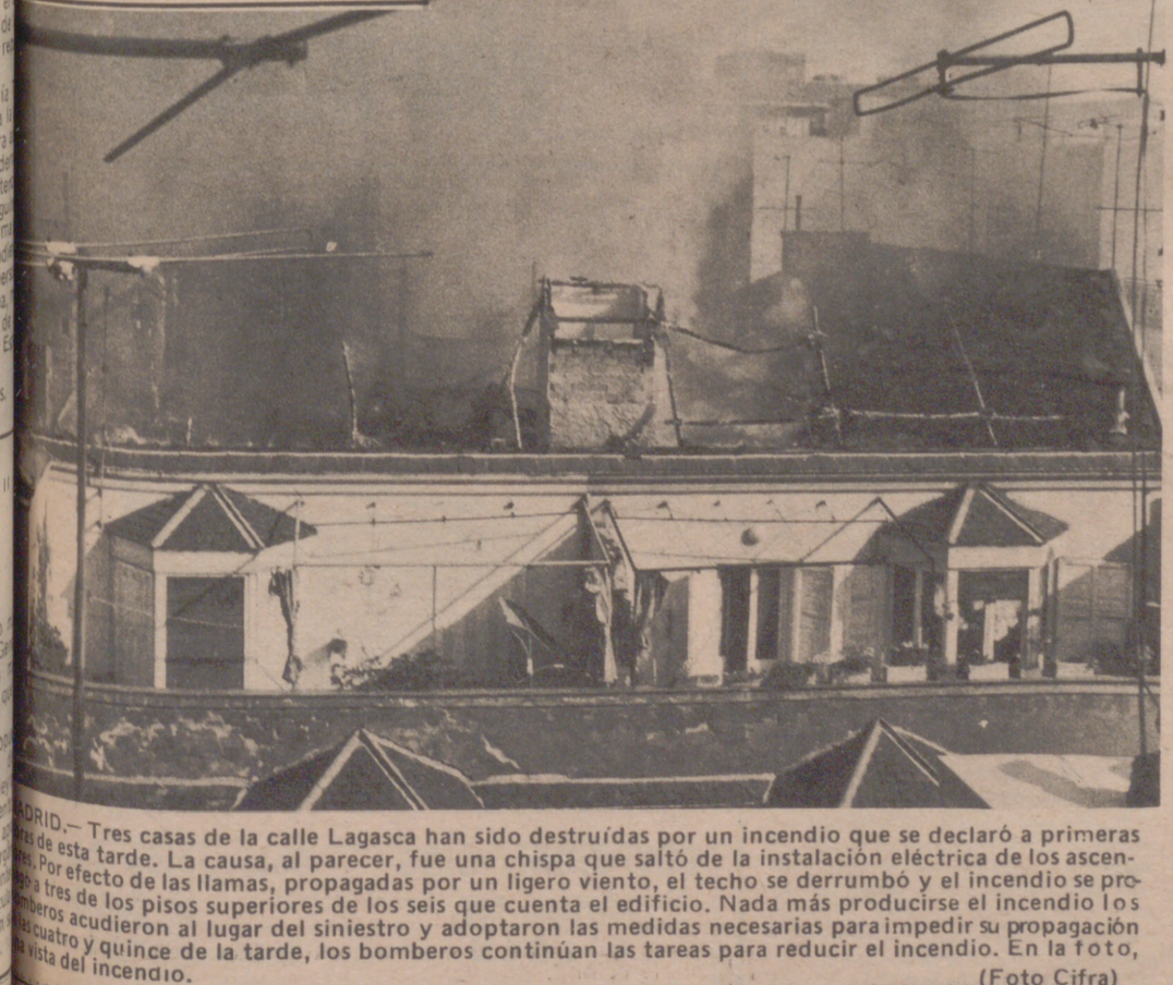
MADRID.— Tres casas de la calle Lagasca han sido destruidas por un incendio que se declaró a primeras horas de esta tarde. La causa, al parecer, fue una chispa que saltó de la instalación eléctrica de los ascensores. Por efecto de las llamas, propagadas por un ligero viento, el techo se derrumbó y el incendio se propagó a tres de los pisos superiores de los seis que cuenta el edificio. Nada más producirse el incendio los bomberos acudieron al lugar del siniestro y adoptaron las medidas necesarias para impedir su propagación. Los bomberos acudieron al lugar del siniestro y adoptaron las medidas necesarias para impedir su propagación. Los bomberos acudieron al lugar del siniestro y adoptaron las medidas necesarias para impedir su propagación. En la foto, la vista del incendio. (Foto Cifra)
