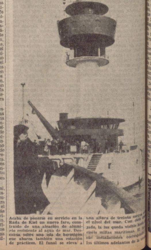
Acaba de ponerse en servicio en la Rada de Kiel un nuevo faro, construido de una aleación de aluminio resistente al agua de mar. Descansa sobre una isla de hormigón que abarca también una estación de prácticos. El faro se eleva a una altura de treinta metros del nivel del mar. Con diez mil faros, la luz queda visible hasta sesenta millas marítimas. El faro sus instalaciones correspondientes los últimos adelantos de la técnica.
