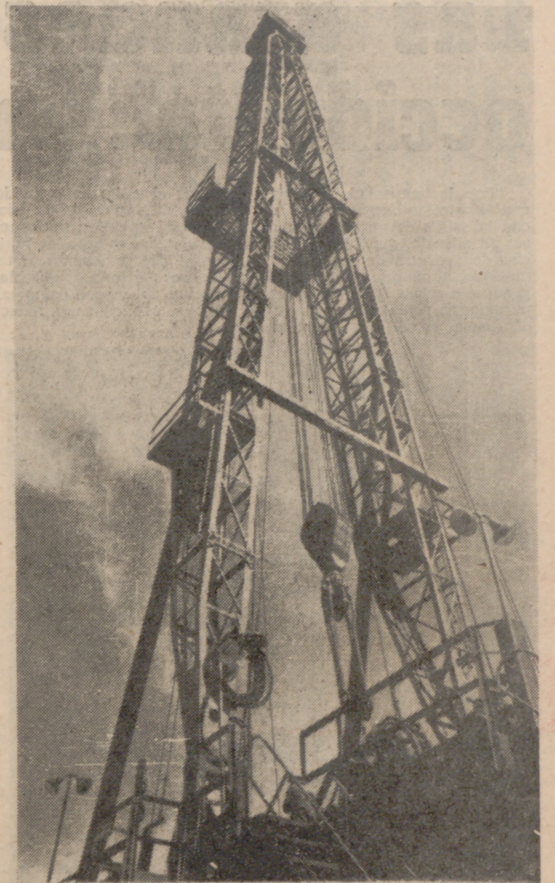
Desde lo alto cae fulminado el eje de perforación: 200, 600, 1.000 metros..., un poco más, y el silbido del gas anunciará lo efectivo de los trabajos.
