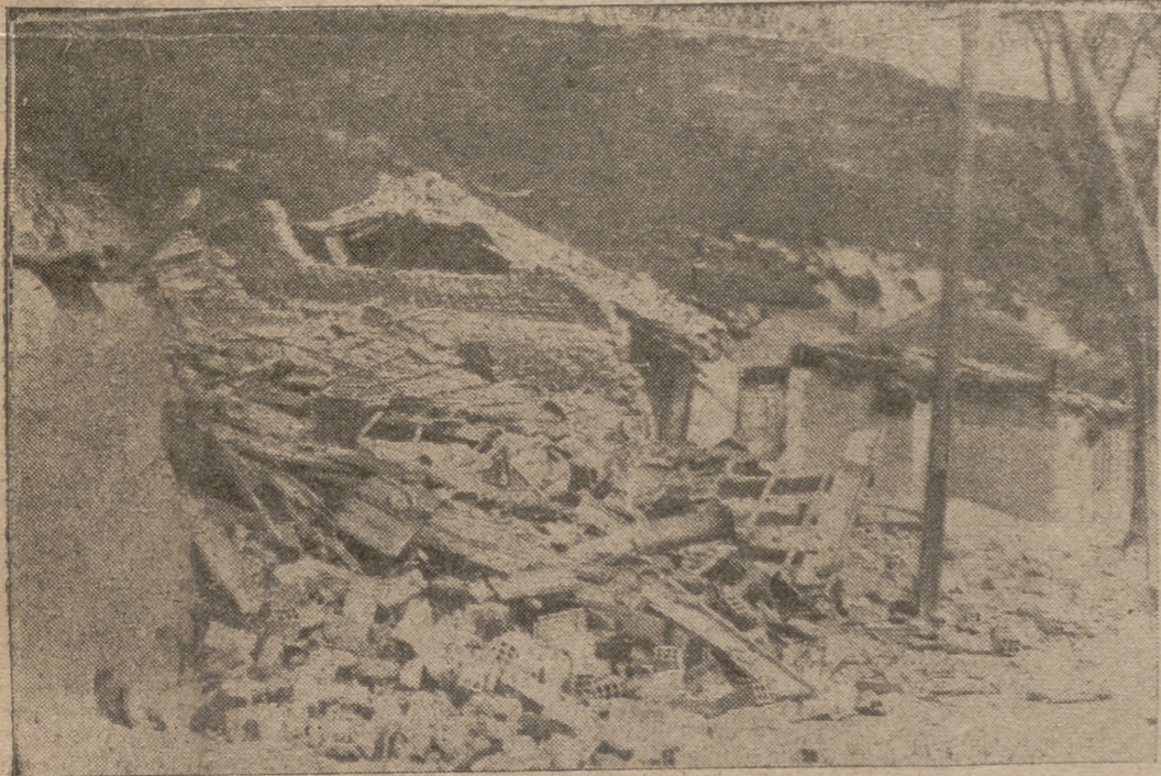
El corrimiento de tierras originó derrumbamientos como éste.
