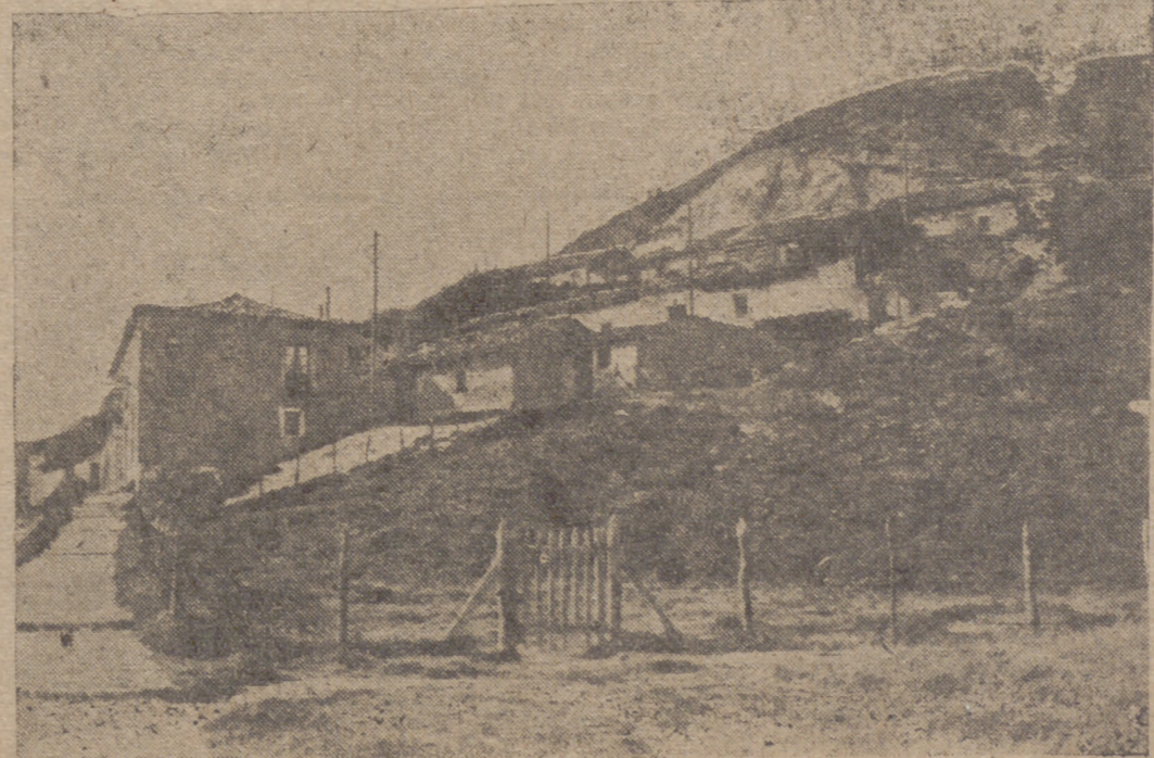
Todo en esta barriada indica zona de peligro en relación con la altura de la montaña.
