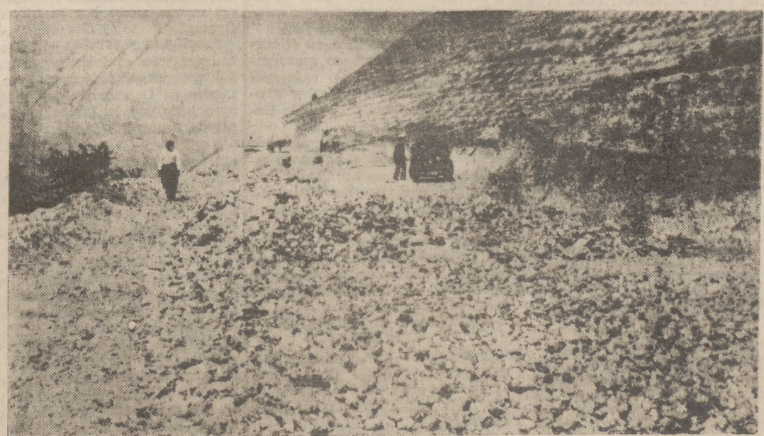
La nueva carretera que se está construyendo para dar acceso a la cumbre del Cerro de San Cristóbal, donde se construirá el gran monumento dedicado a la memoria de Onésimo Redondo.
