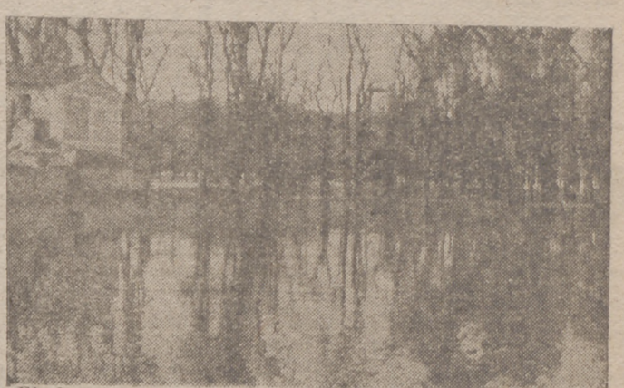
El desbordamiento del Ebro produce inundaciones en Zaragoza.—Un aspecto de la inundación
