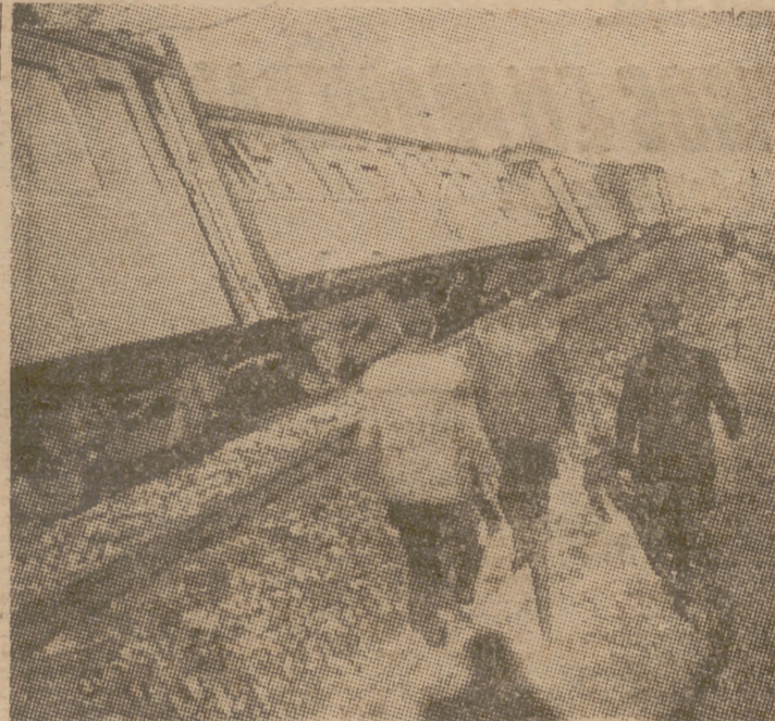
Un aspecto de los tres vagones del expreso Vigo-Madrid, que descarrilaron esta mañana.
