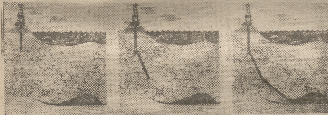
La perforación de petróleo de manera oblicua es un método de hacer hoyos sesgados expresamente. El primer paso (izquierda) es taladrar un hoyo vertical a varios cientos de pies de profundidad. Al llegar a ese punto se introduce por el agujero un tubo de acero de unos nueve pies de largo, con un ángulo de tres grados formado en su interior. Por cada 100 pies perforados, este tubo altera el sesgo del agujero en tres pies. Para llegar al objetivo, que es un yacimiento de petróleo submarino (centro), el tubo se curva hacia el mar (derecha). Si el yacimiento es una zona relativamente poco profunda, el tubo puede perforar un agujero de un ángulo de 80 grados del equipo de tierra.
