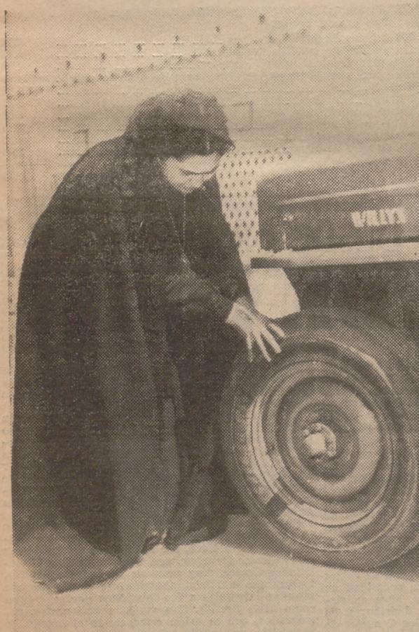
Y si llega el momento difícil de tener que arreglar un pinchazo, la Hermana no lo duda ni por un momento. Comprueba el estado de la rueda, saca el gato, desmonta el neumático, pega el parche, infla la cámara y de nuevo, solucionado el percance, sigue calle arriba, aún más de prisa, para adelantar el tiempo perdido y poder trasladar al enfermo al hospital sin más contratiempo. (Foto Guillén.)
