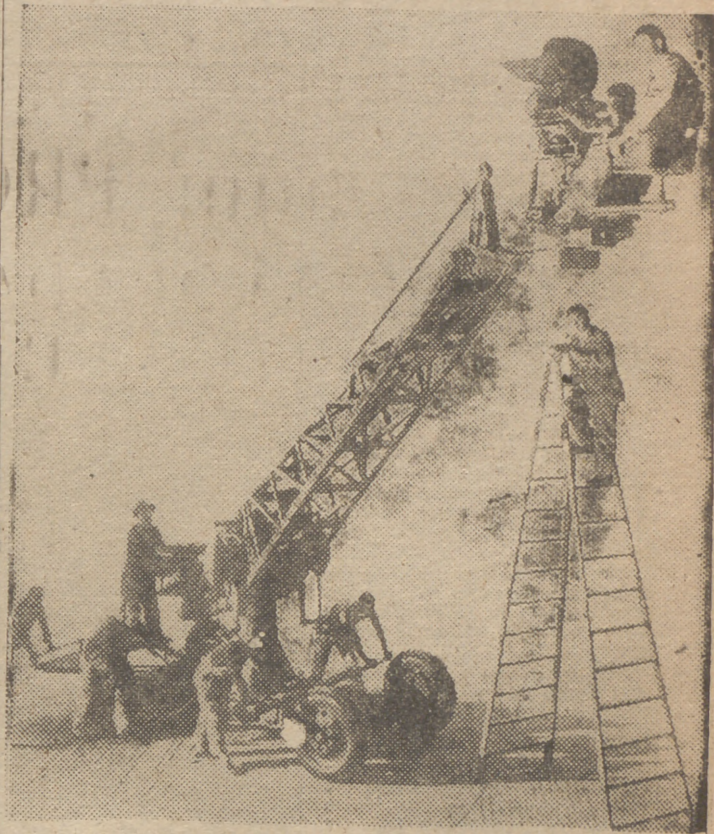
Cámara emplazada sobre la plataforma de la grúa
