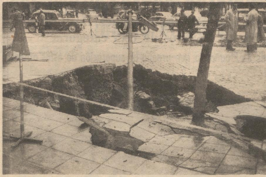
El socavón de hoy se ha producido en la calle de Luchana, ca si esquina a la de Trafalgar. Tiene unos cuatro metros de largo por dos de ancho y uno y medio, aproximadamente, de profundidad. A pesar de la frecuencia con que se producen los socavones, el de hoy está siendo muy visitado. (Foto Verdugo.)
