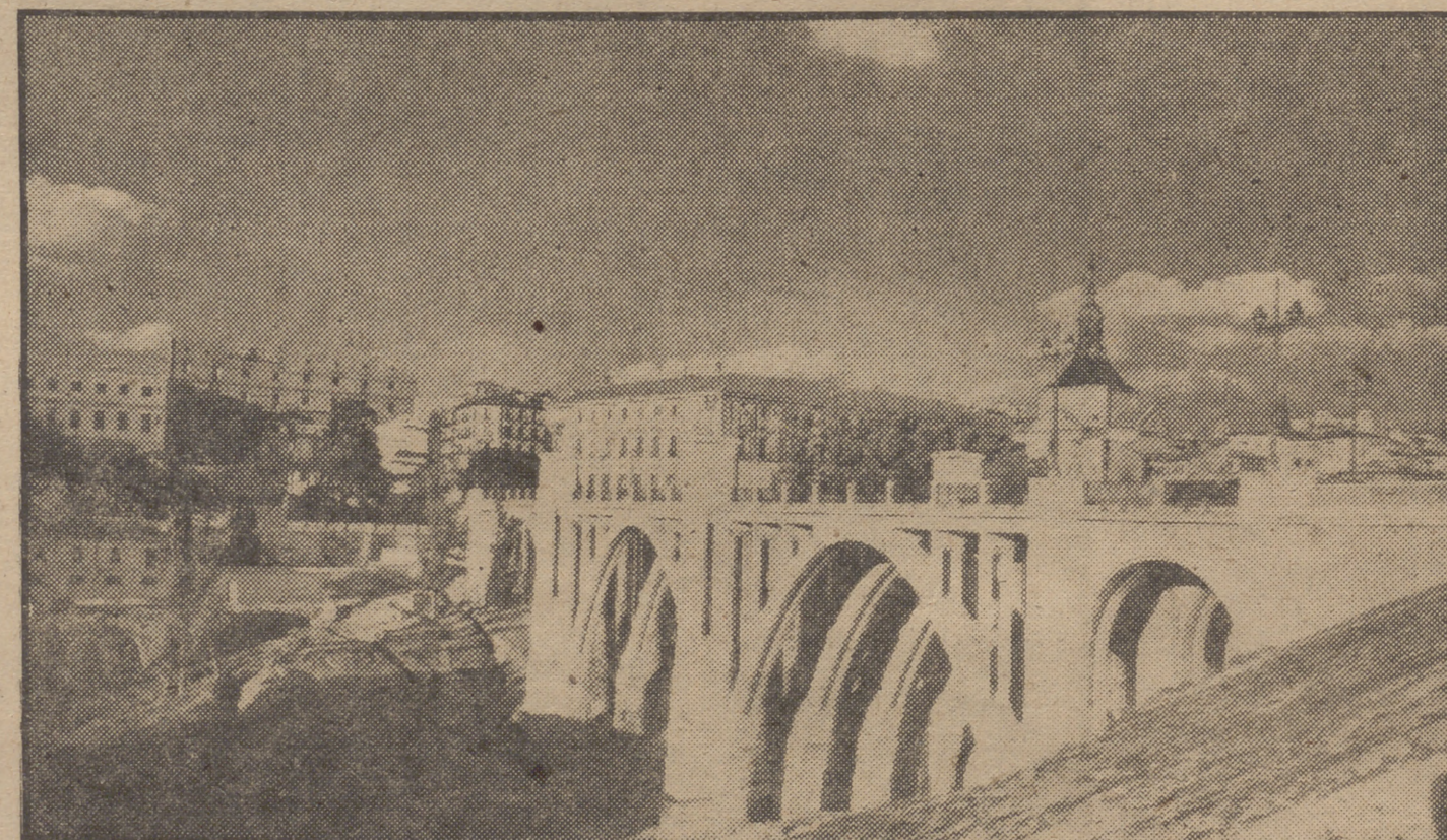
El viaducto de la calle de Ballén.
