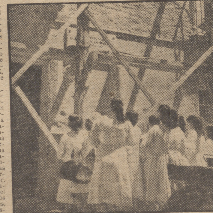
Aquí nació Cervantes. La casa está en reconstrucción.
