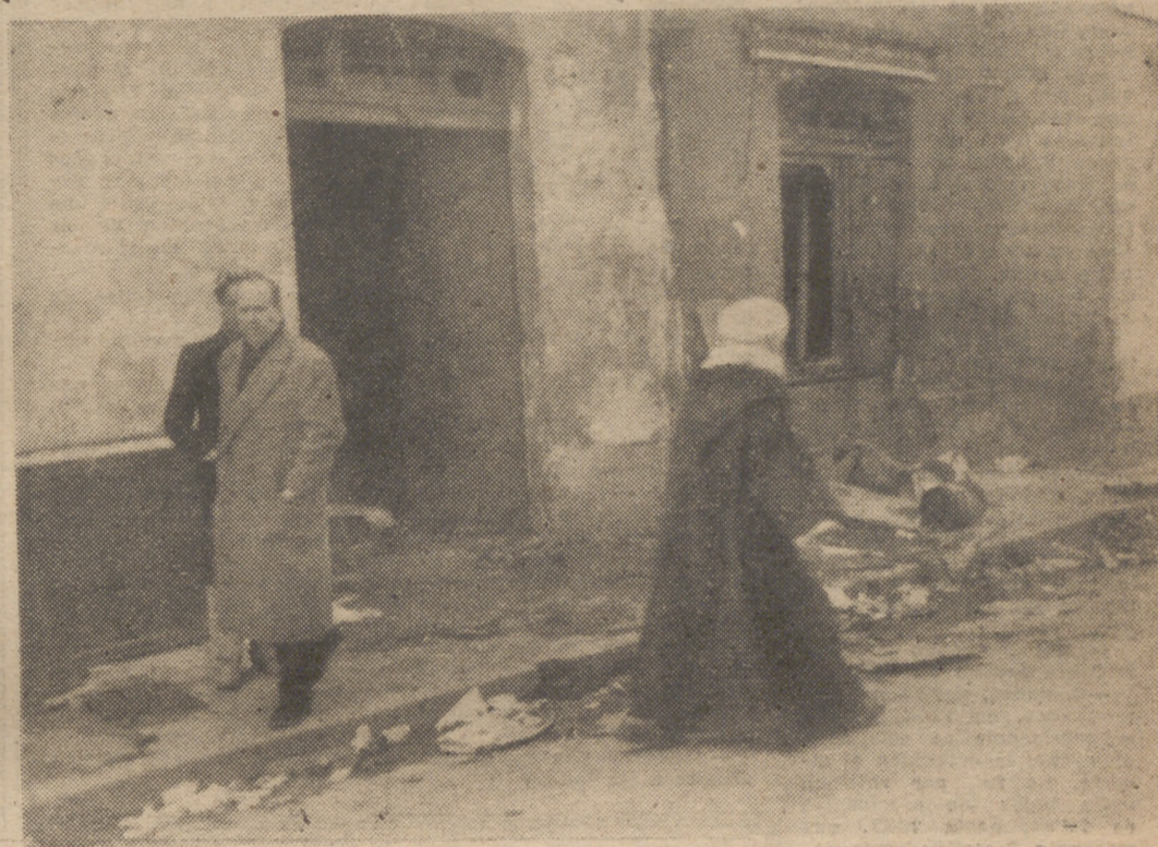
En Argelia se produjeron, como ya es sabido, numerosos y graves incidentes con motivo de la partida del que era gobernador general, Soustelle. Vemos en nuestra foto el estado en que quedó, en Orán, un edificio atacado por los revoltosos, al que, después de haber sido saqueado el mobiliario que hallaron en su interior, prendieron fuego. (Foto Cifra.)
