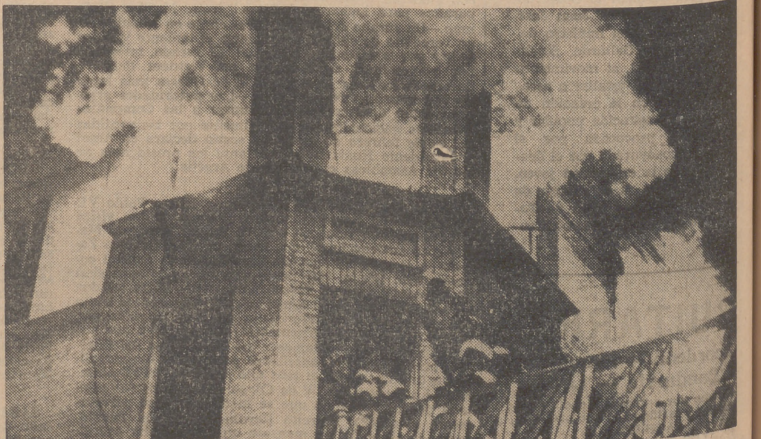
Las llamas dan un aspecto terriblemente espectacular a este edificio de cinco plantas, que, presa del fuego, ardió completamente en la ciudad de Boston. Aun cuando se tiene noticias de la muerte de cuatro personas, se cree que entre los restos humeantes del edificio serán hallados los cuerpos calcinados de otras víctimas
