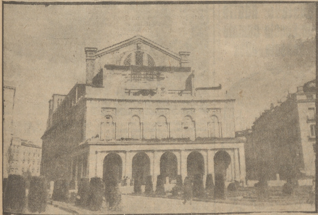
Fachada a la plaza de Oriente del Teatro Real, durante las largas obras de su restauración. La noticia de una posible Ayuda March para la conclusión de la reconstrucción ha hecho que salte a la actualidad la vieja historia del teatro, que lleva treinta y siete años cerrado
