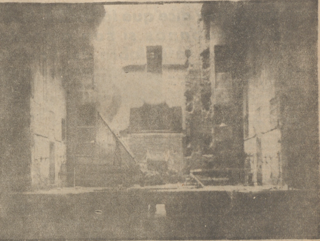
Una vista del escenario del teatro Real, de Madrid, cuando se iniciaba su reconstrucción, ya concluida. En la fotografía se aprecian las colosales dimensiones de la embocadura del escenario
