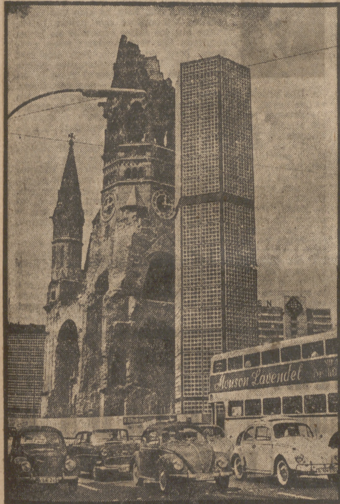
Junto a las ruinas de la Votivkirche, la Iglesia que erigió Guillermo I, la estructura de la nueva en construcción. A los dieciséis años de la terminación de la guerra, las tres cuartas partes de la capital estaban íntegramente reconstruidas
