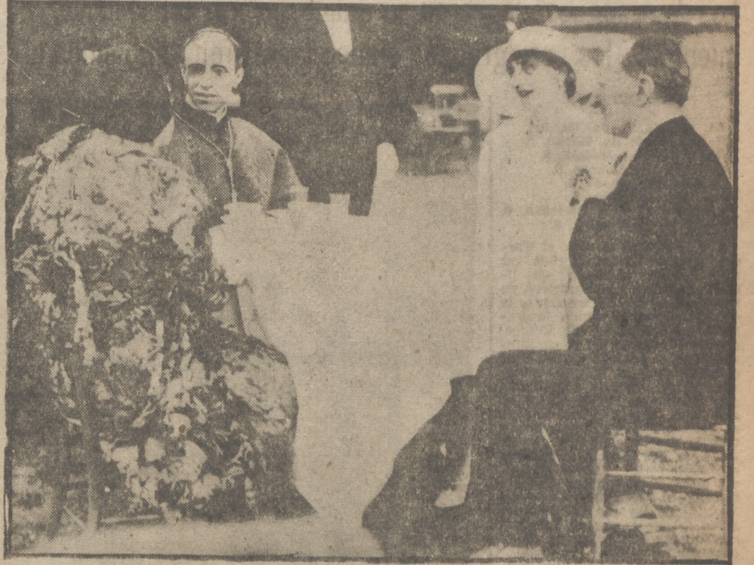
Pío XII con el célebre inventor Marconi, durante una recepción. Su Santidad, por motivos de sus cargos anteriores a su ascenso al trono de San Pedro, había mantenido relaciones muy directas con los prohombres de la época.
