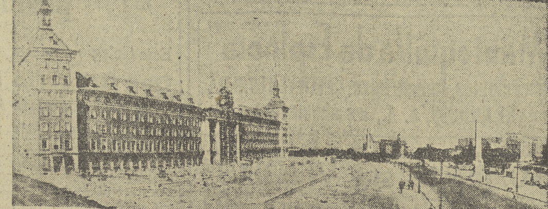
El nuevo y maravilloso edificio del Ministerio del Aire. Con el como muestra un avance de lo que ha de ser la perspectiva de la madrileña Plaza de la Moncloa, en una de las más nobles entradas de la ciudad. Al fondo de la calzada, las obras de levantamiento del arco triunfal del Caudillo.
