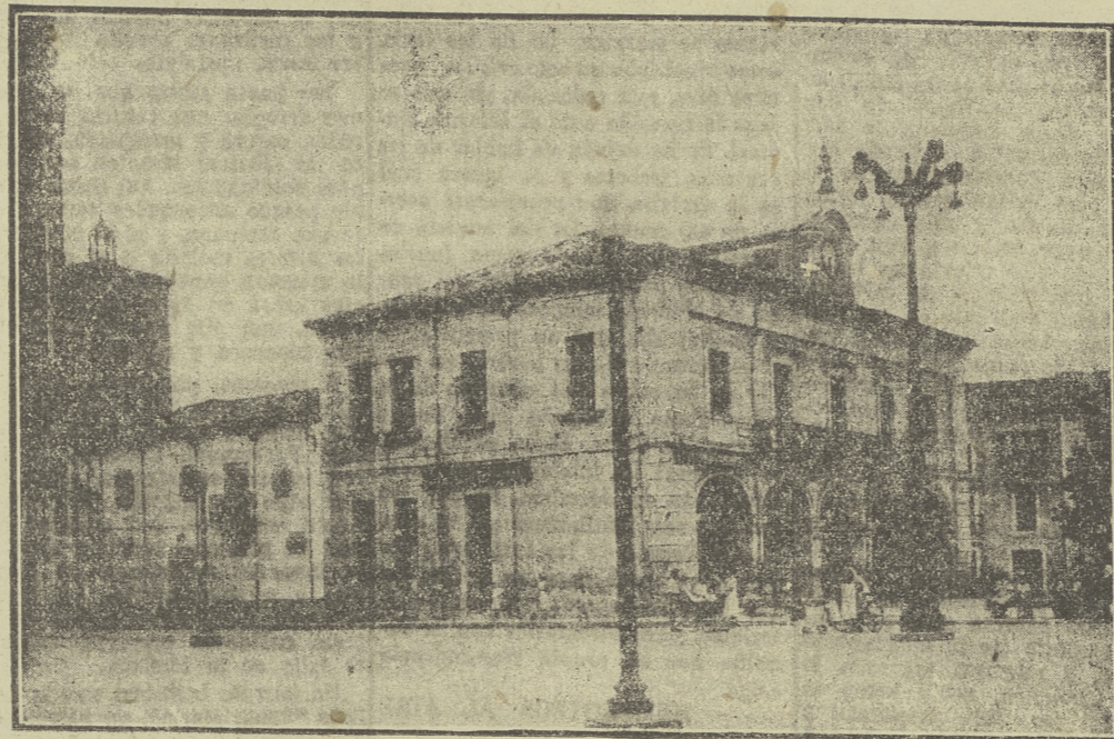
Casa Consistorial de Villarcayo, donde se hallan instalados, no sólo los servicios administrativos, sino el Juzgado y la estación de telégrafos.
