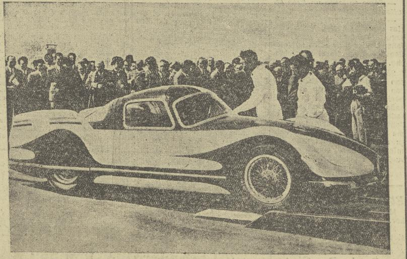
El nuevo automóvil «Fiat» con motor de turbina durante las pruebas de ensayo sobre la pista de arranque del aeropuerto de Casella, donde ha rebasado los 200 kms. por hora.
