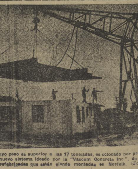
Un tejado de cemento, cuyo peso es superior a las 17 toneladas, es colocado por presión atmosférica mediante un nuevo sistema ideado por la "Vacuum Concrete Inc.", de Filadelfia, sobre una de las parrillas prefabricadas que están siendo montadas en Norfolk. (Foto UPI)
