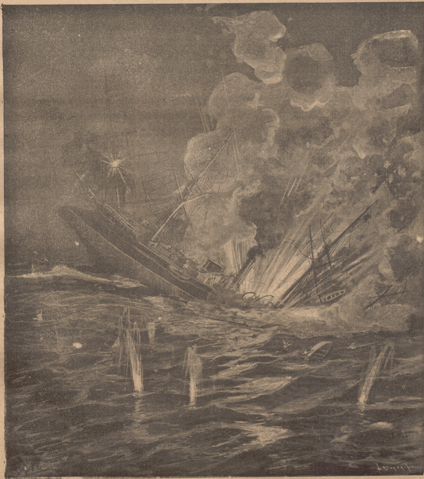
EXPLOSION DE LAS CALDERAS DESPUES DEL CHOQUE CON EL «MORTERA»
