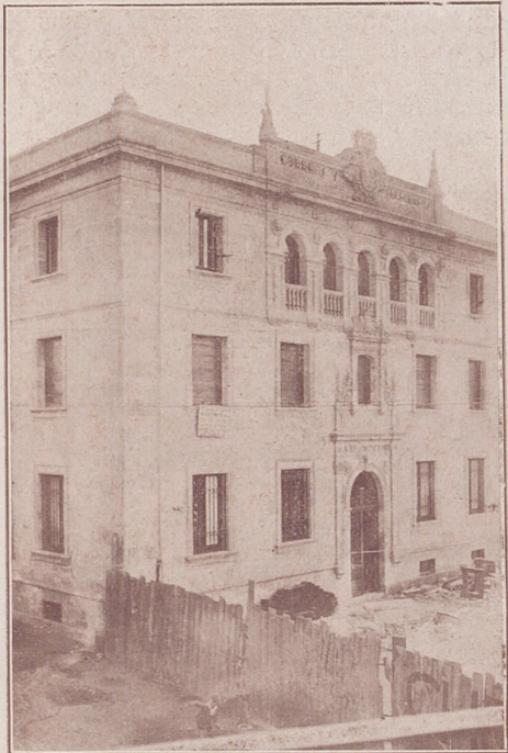
Casa de Correos, en construcción.
