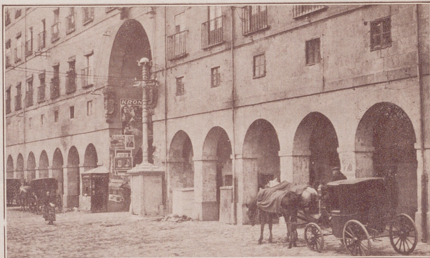
En el exterior de estos portales, la fábrica se alza gigantesca con ventanas y balcones simétricos.
